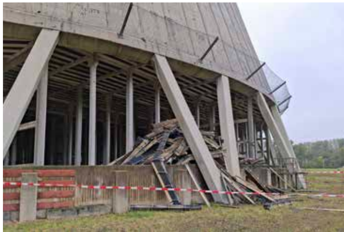
Entfernen der Kühlturmeinbauten
