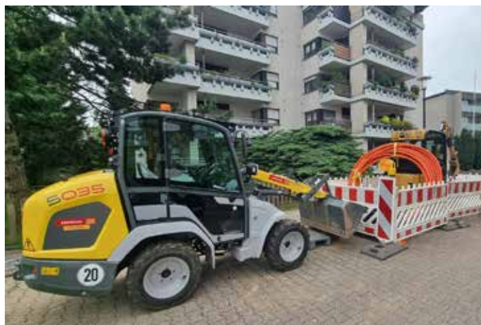
Vorbereitung der Glasfaserkabelverlegung
